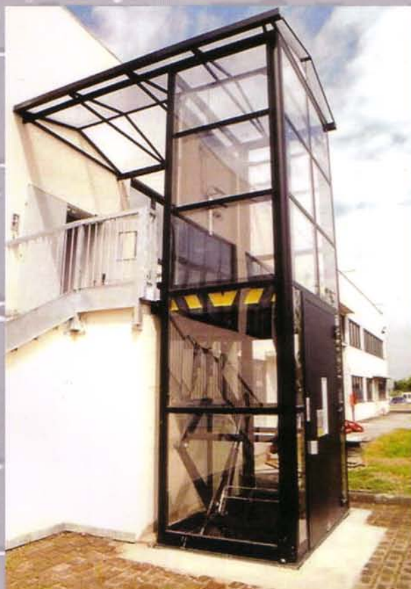
23 Piattaforma elevatrice autoportante con sistema di sollevamento a pantografo
