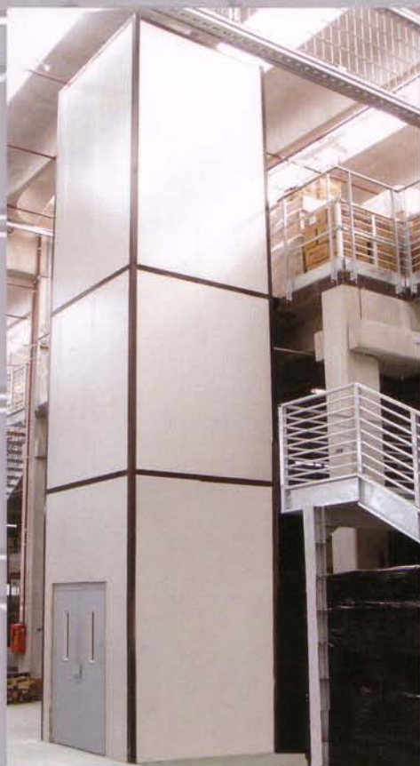
22 Piattaforma elevatrice autoportante con sistema di sollevamento ad arcata
