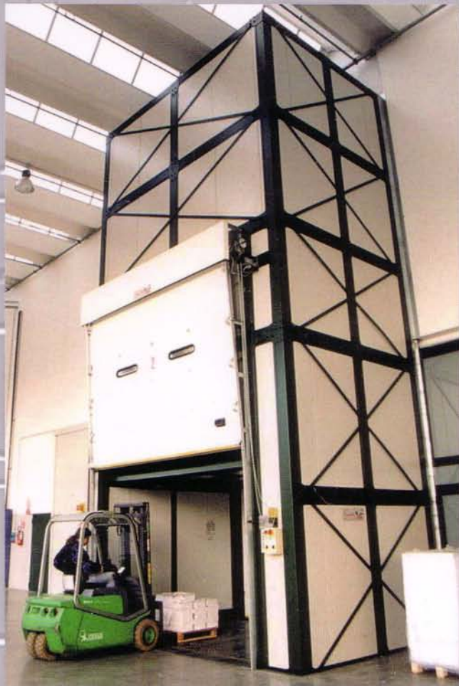
20 Piattaforma elevatrice autoportante con funzionamento a montante per il raccordo tra più piani del magazzino
