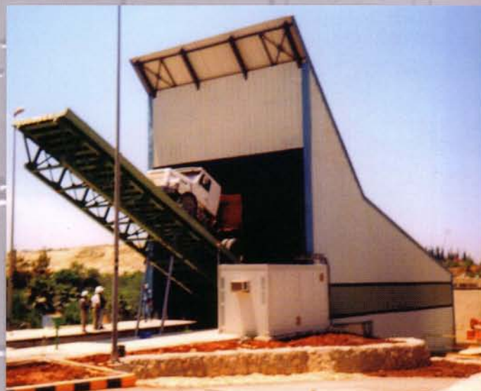
10 Rampa per ribaltamento automezzi.
